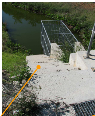
1 Descente escalier et buse entrée avec grille
