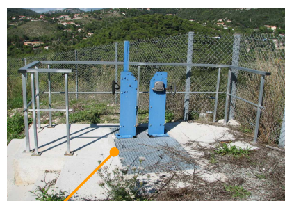
2 Regard by-pass entrée avec 2 vannes à volant
