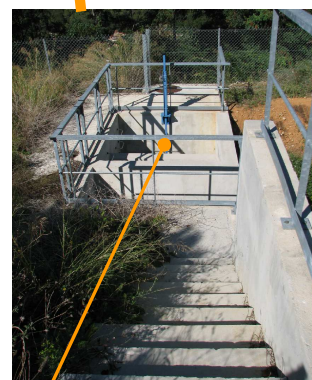
4 Vanne à volant sortie bac déshuileur illeur
