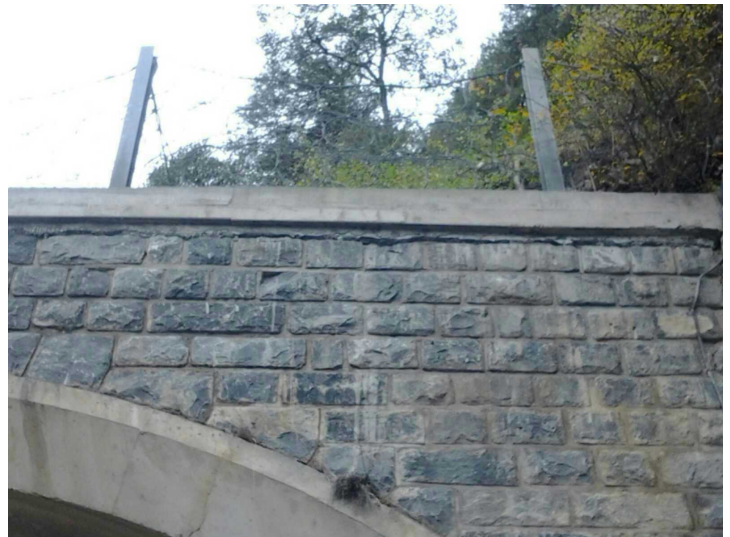
C -- 19/11/2018 10:55:26 Fracture tête avec longrine supérieur
