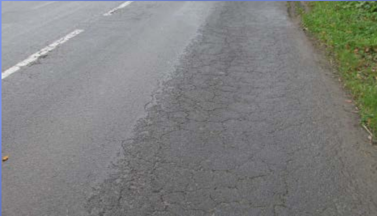
Faiencage et fissures longitudinales en rive
