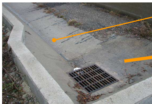
1 Caniveau béton avec grille avaloir
