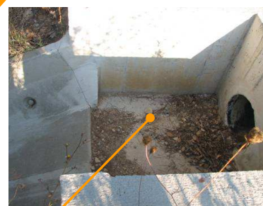
Buse et descente béton de sortie du by- pass
