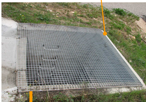
3 Caillebotis sur regard entrée du by-pass avec vanne à crémaillère
