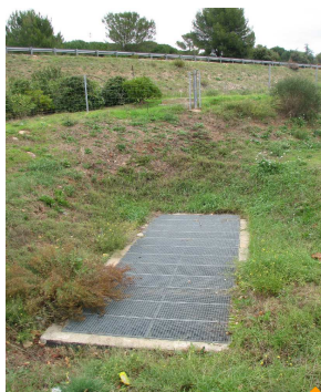
8 Regard caillebotis de sortie du by-pass
