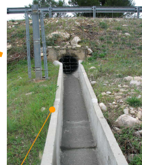
1 Buse et descente béton
