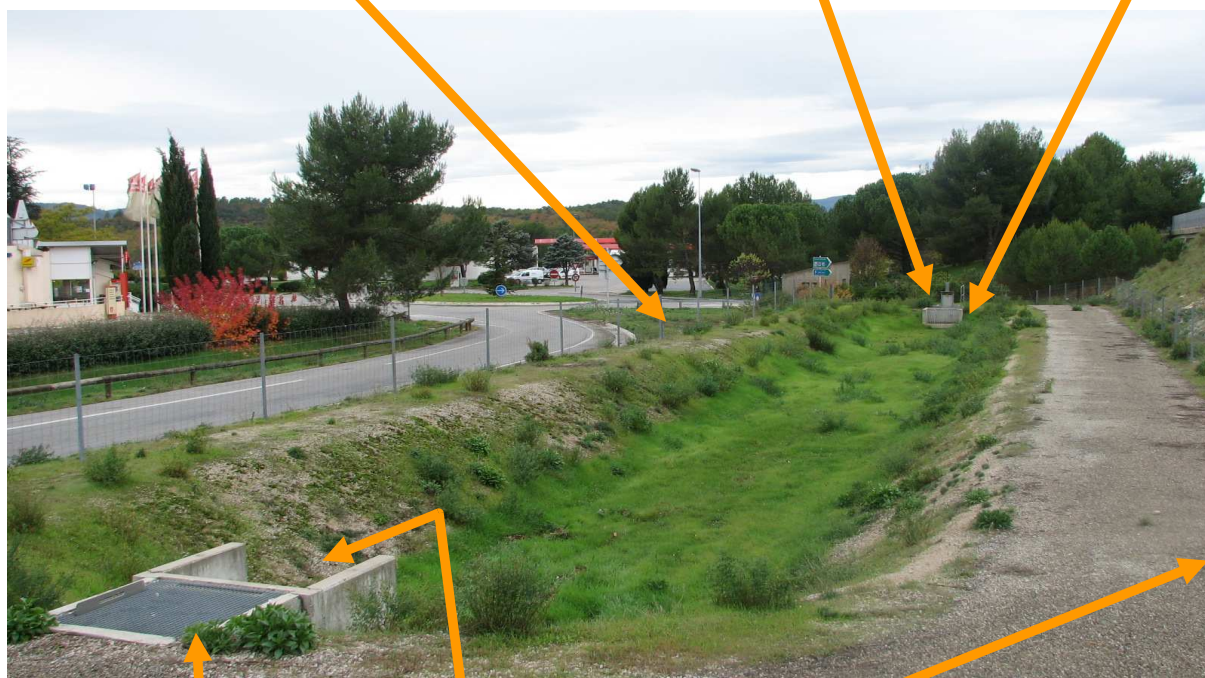
8 Regard caillebotis de sortie du by-pass
