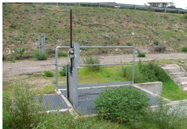
6 Regard cloison siphonide avec vanne de sortie
