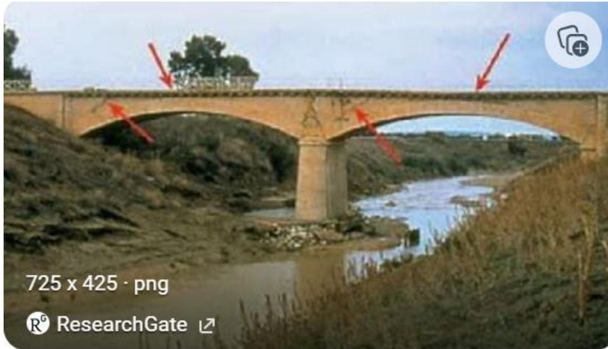
24: Tassement de la pile médiane d'un pont due à l'affouillement local ...
