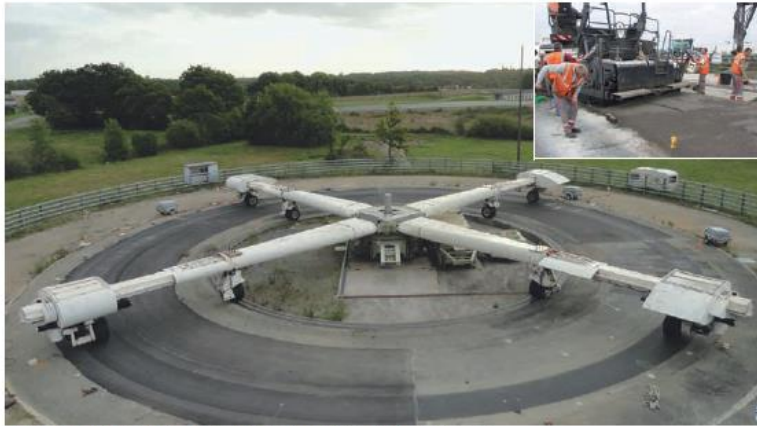
Le manège de fatigue de l'IFSTTAR et vue de la construction des structures Recyroute IFSTTAR fatigue test track and view of construction of Recyroute structures
