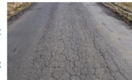
L'arrachement de la couche de roulement peut se présenter par plaque (pelade), par un arrachement des gravillons du revêtement (plumage), par un départ de gravillon se développant suivant des sillons parallèles à l'axe de la chaussée (peignage), ou encore par un départ du liant autour des granulats (désenrobage).
