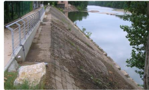
AL-Zûmars-01MB Type: Mur - Visite SOA Structure: Talus revêtu d'éléments béton Voie: Pl Place du 19 Mars 1962
