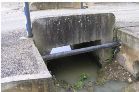
MN-VC013-010A Type: Pont - Visite SOA Structure: Cadre fermé PICF
