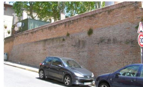
MN-Zûdupu-01MA Type: Mur - Visite SOA Structure: Mur revêtu
