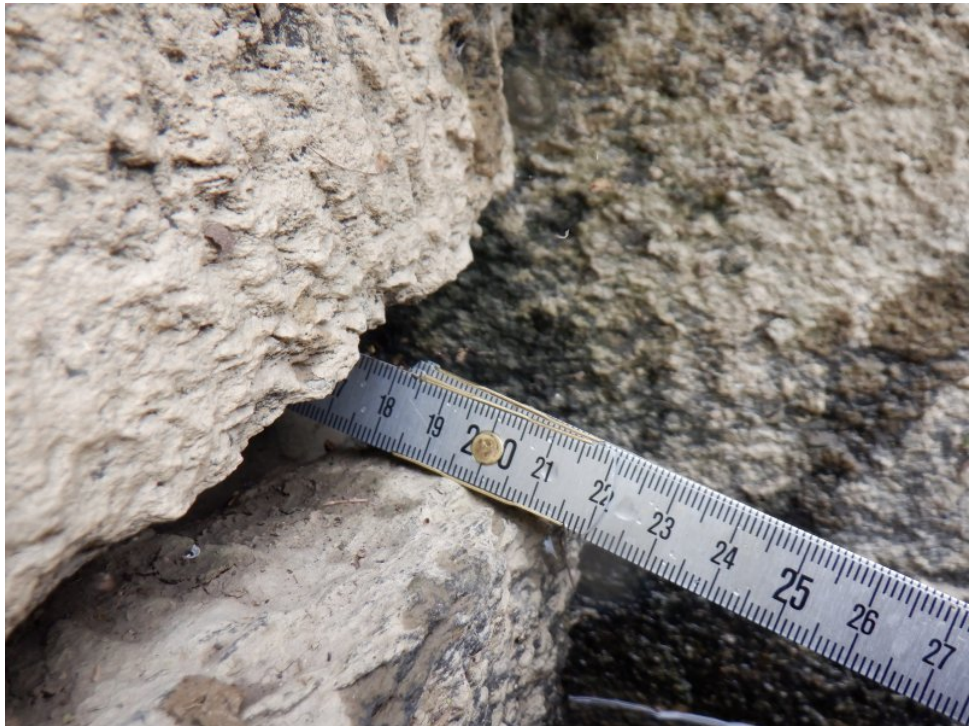
P1 disjointoiment, vue type
