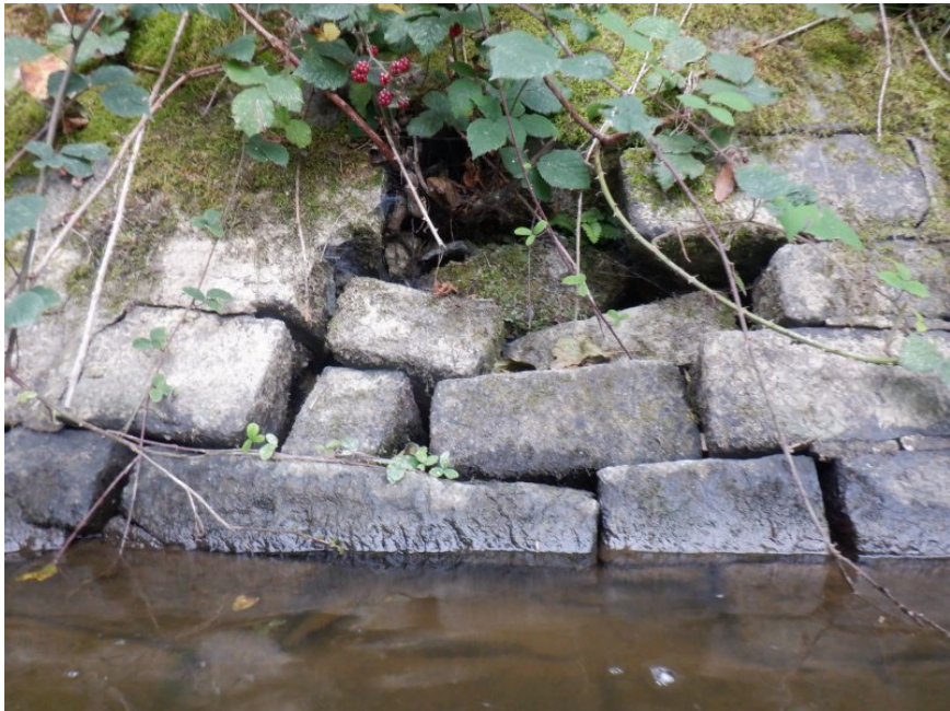
Mouvement de maçonnerie Quart de cône maçonné Rive Droite
