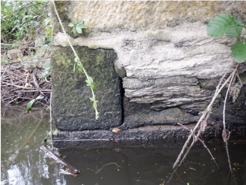
Culée rive gauche : disjointoiement
