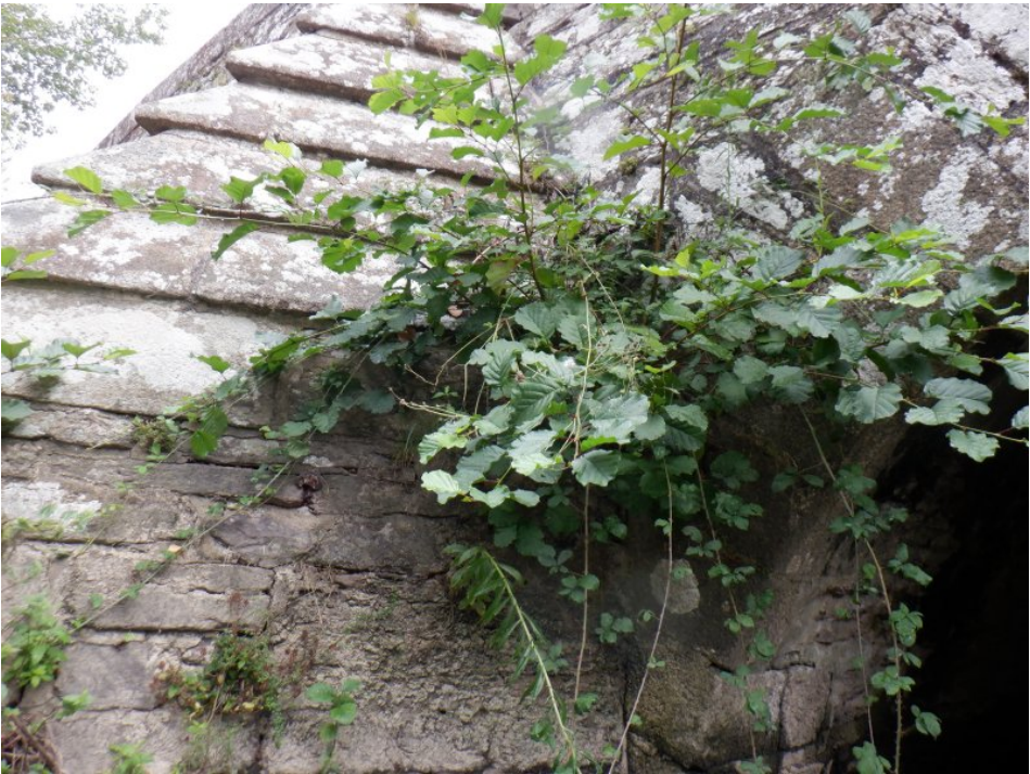
Arrière bec fcae gauche de P2 : végétation parasite arbustive
