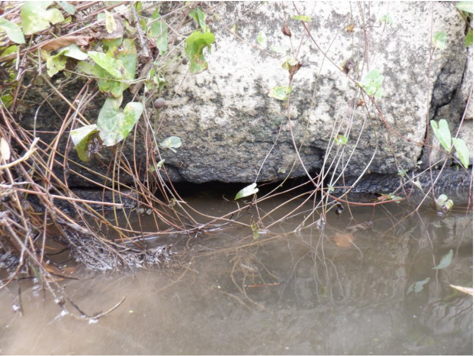
Avant bec face droite de P2 : maçonnerie manquante
