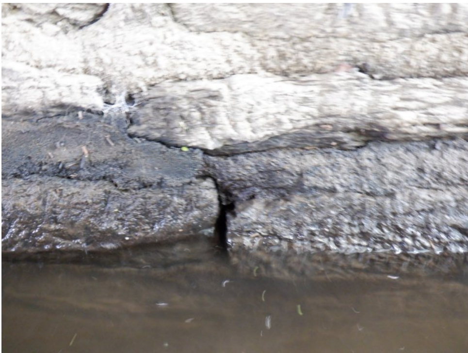
P2 : disjointoiement en zone de marnage
