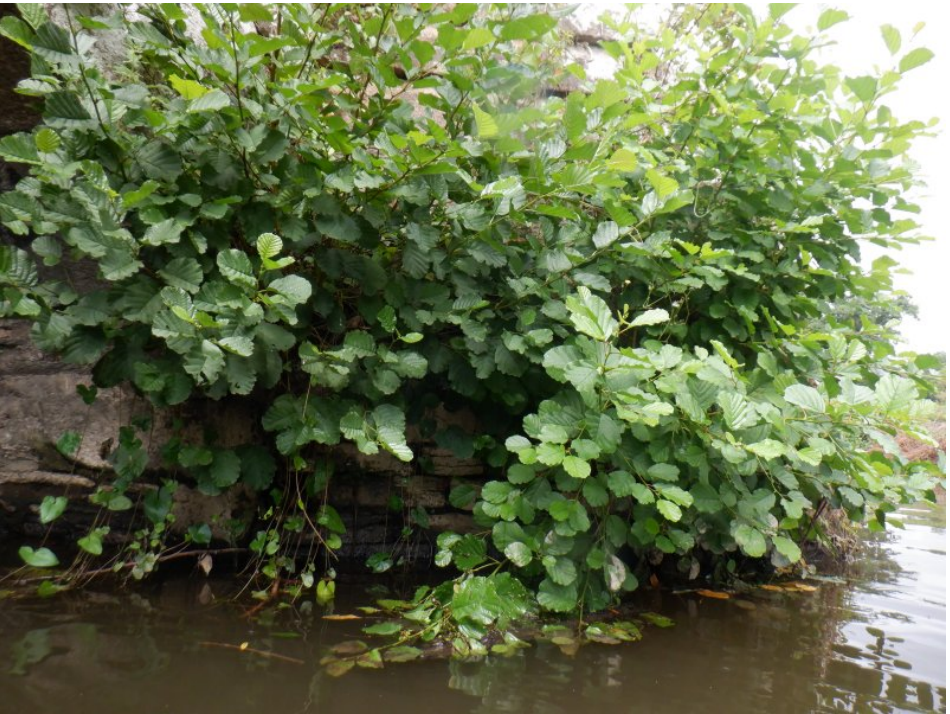
Avant bec face gauche de P2 : végétation parasite arbustive
