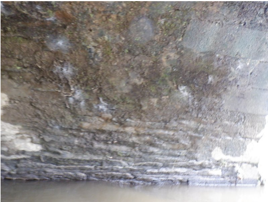
Arrière bec face droite de P1 : infiltration
