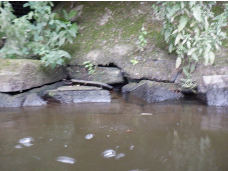
Mouvement de maçonnerie Quart de cône maçonné Rive Gauche Amont
