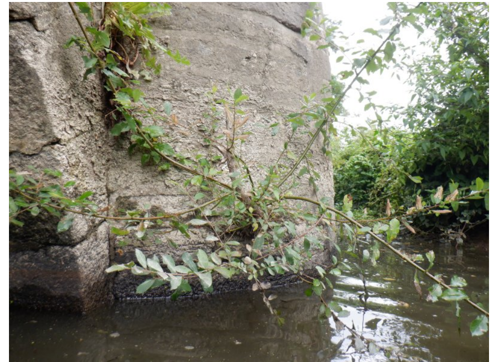
Culée rive droite amont : végétation parasite arbustive
