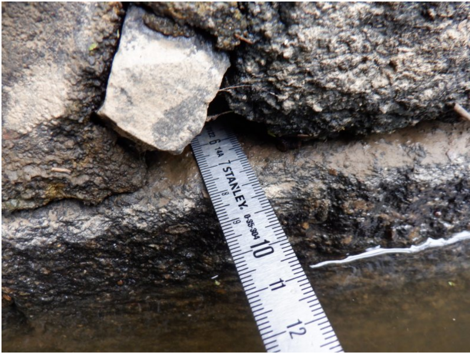
Avant bec de P3 : disjointoiment
