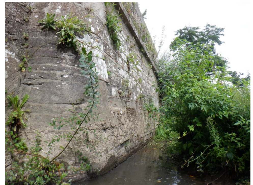
Culée rive droite amont : mur retour
