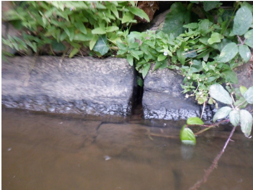
Disjointoiement de la maçonnerie du quart de cône en Rive Gauche Aval
