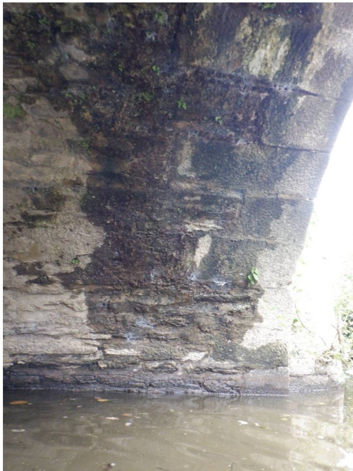
Culée rive droite amont : infiltration
