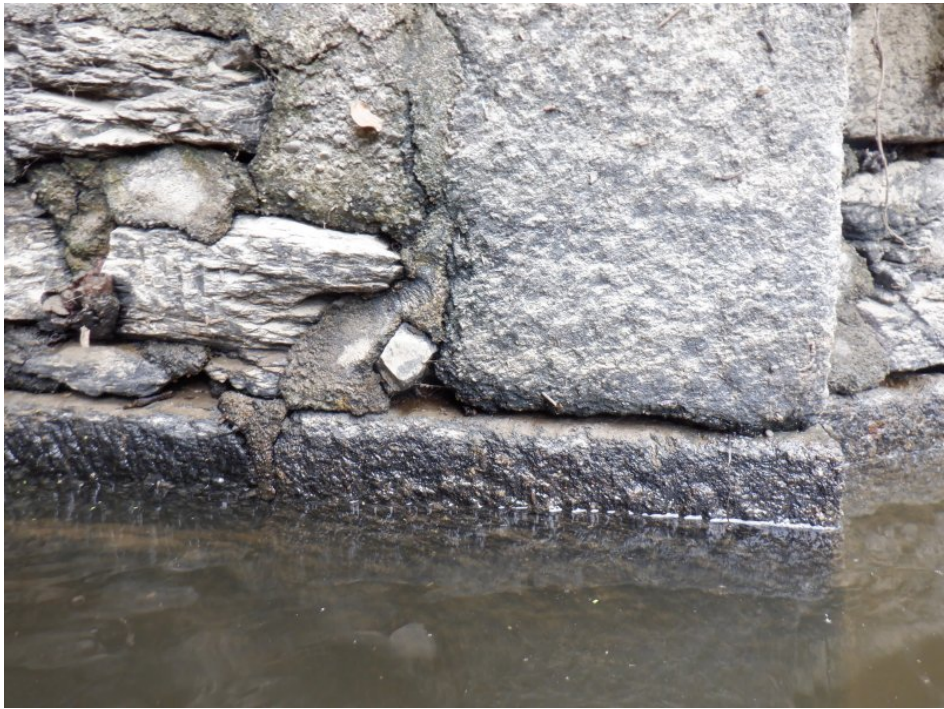
Avant bec de P3 : disjointoiment
