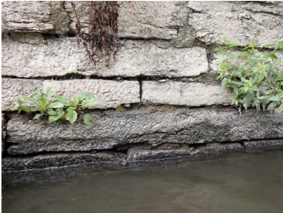
Avant bec de P1 : disjointoiment
