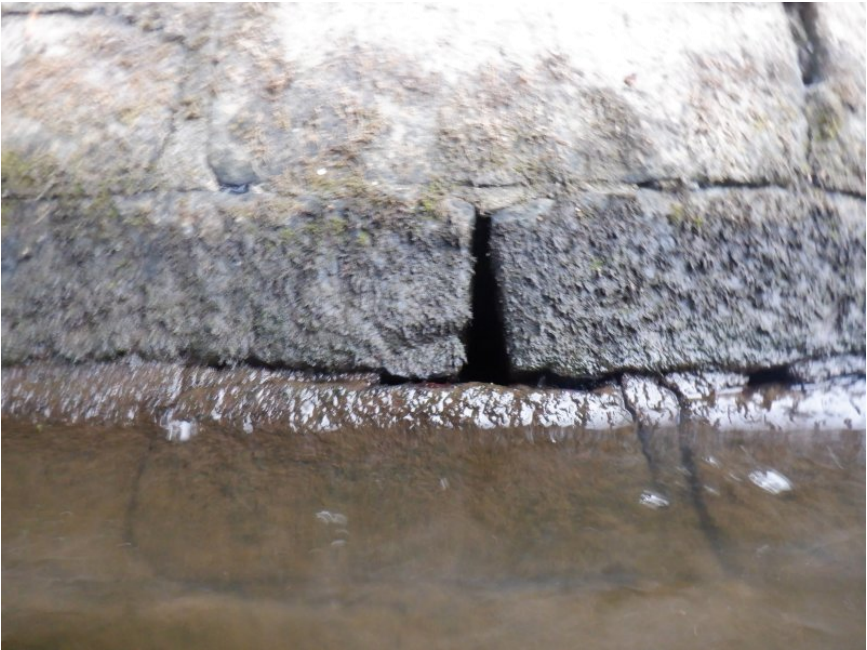
Disjointoiement de la maçonnerie du quart de cône en Rive Droite Aval
