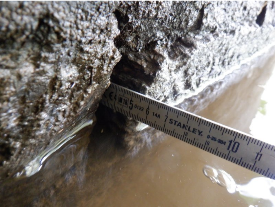
P2 : disjointement, vue type
