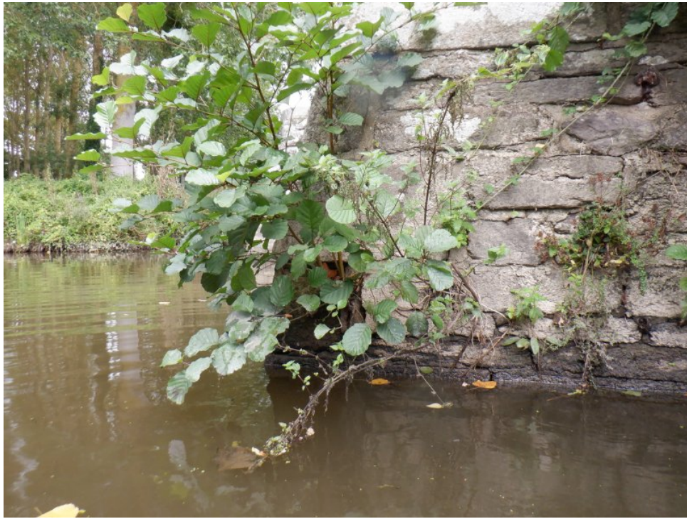
Arrière bec de P2 : végétation parasite arbustive
