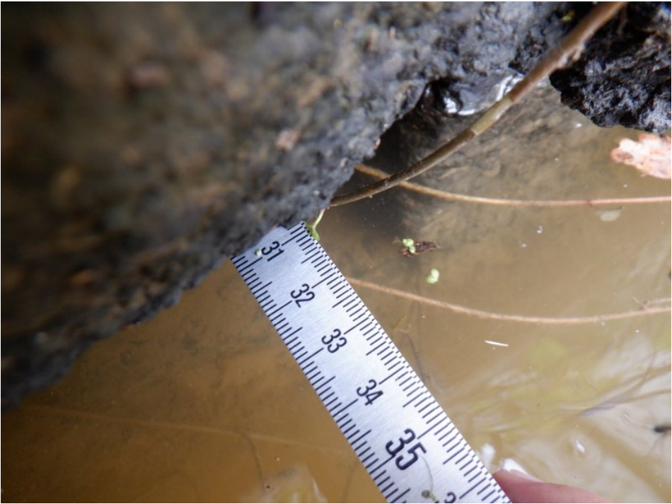
Avant bec face droite de P2 : maçonnerie manquante, vue type
