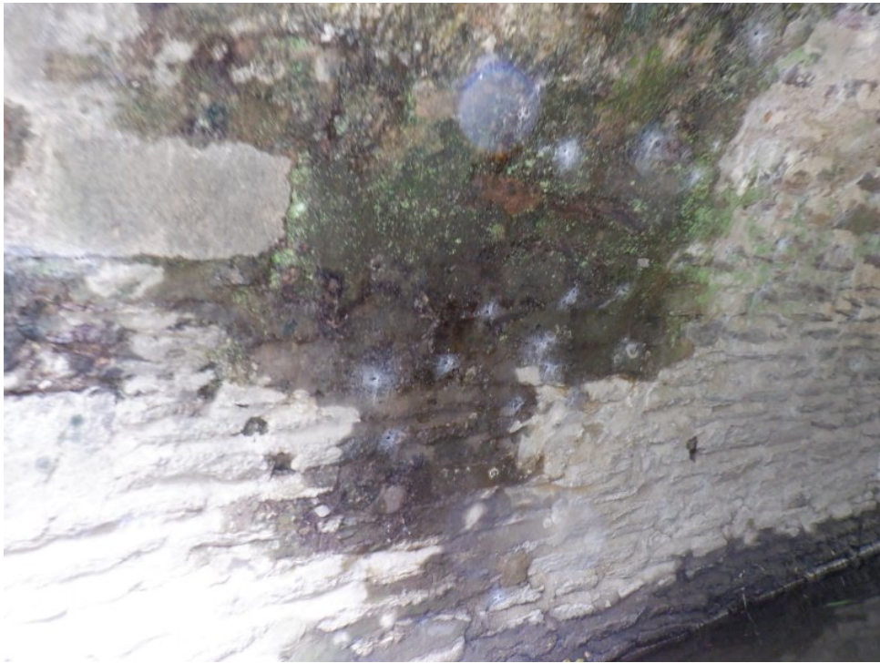
Face gauche de P2 : infiltration
