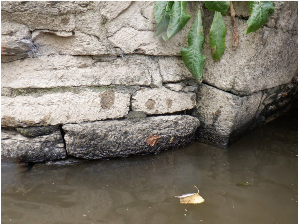
Avant bec face droite de P1 : disjointoiment
