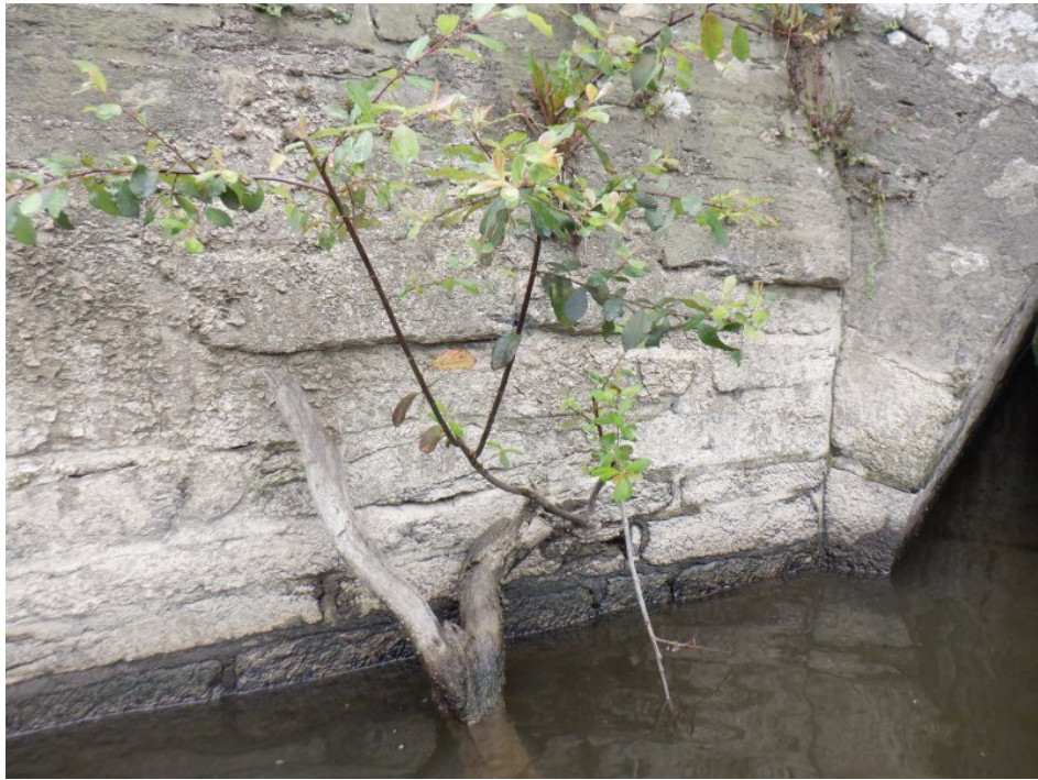
Avant bec face droite de P3 : végétation parasite arbustive
