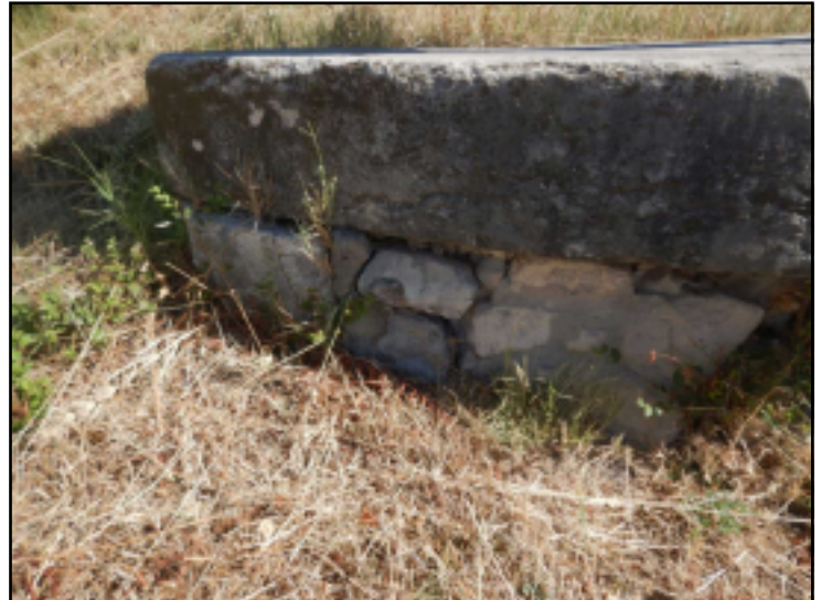
D -- 21/07/2022 14:09:09 Disjointement de 40x40cm sur mur en retour C1 côté ouest.
