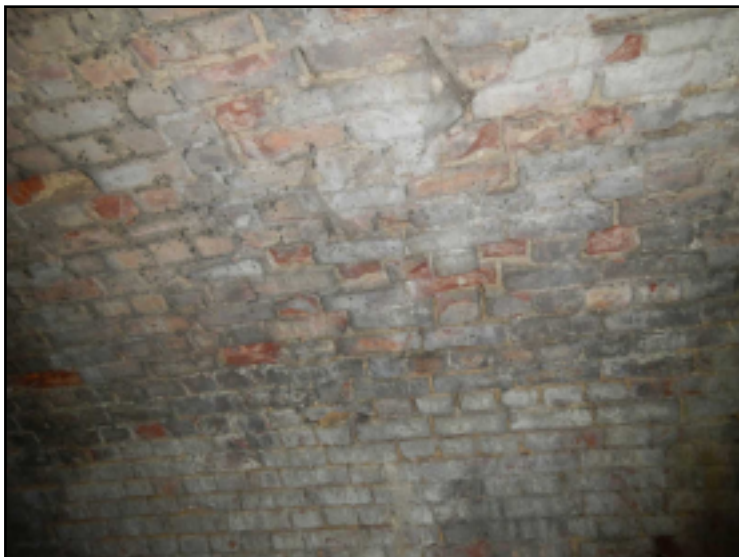
R -- 08/12/2022 16:43:52 altération de brique
