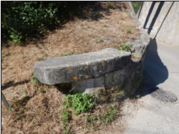
E -- 21/07/2022 14:10:56 Pierre déplacée de 45cm sur mur en retour C0 côté Est.
