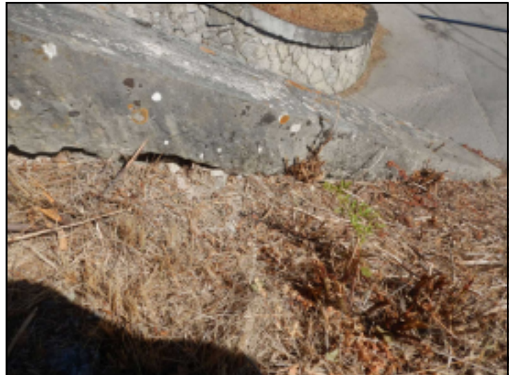
F -- 21/07/2022 14:12:18 Ravinement de 15cm en tête du mur en retour C0 côté Est.
