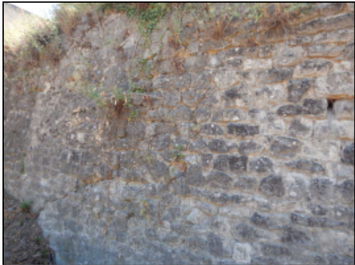
K -- 22/07/2022 17:17:11 Disjointement de dimension 8×4m au PM106
