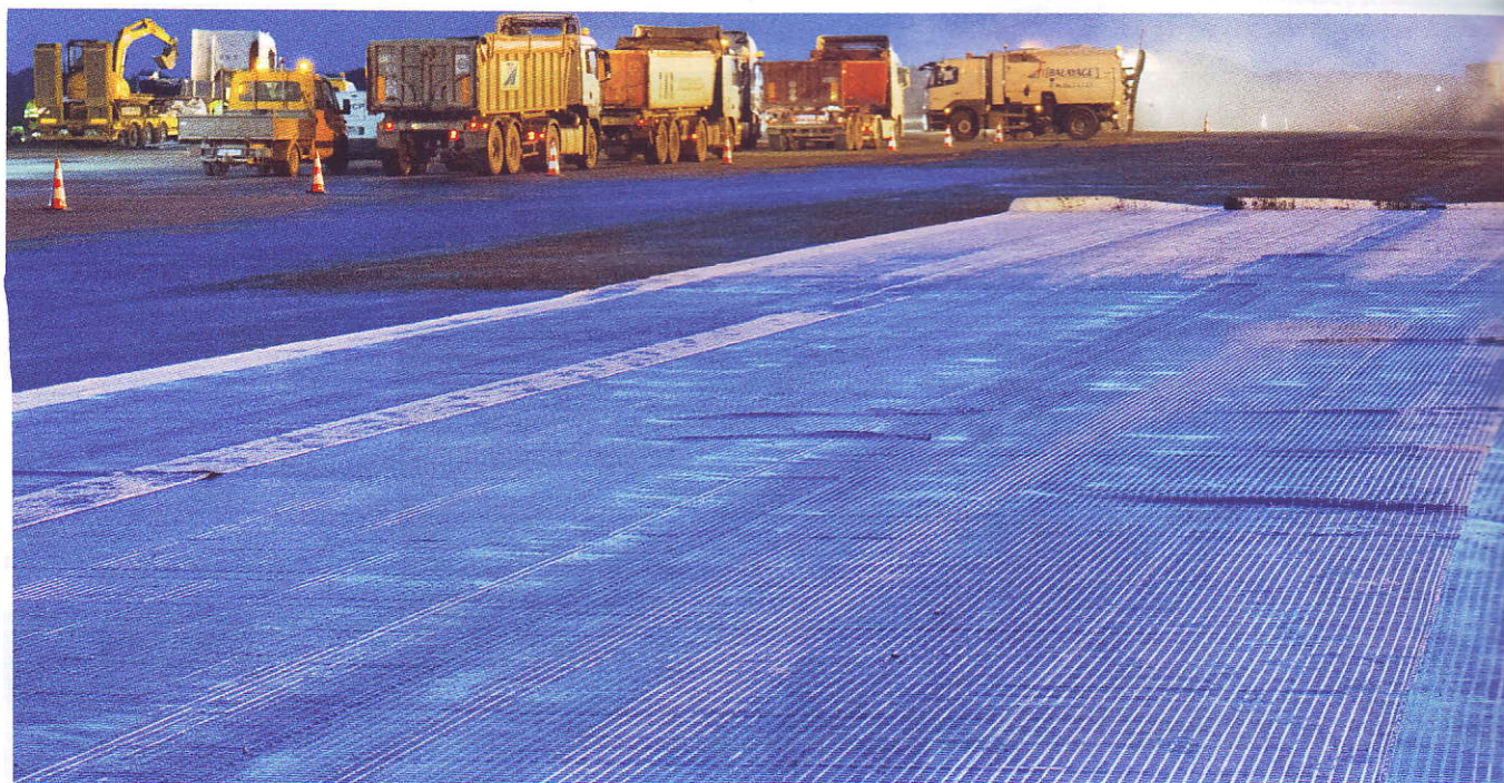
Chantier de l'aéroport de Beauvais : mise en œuvre de la géogrille.
